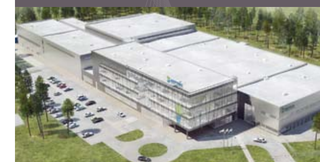
Проект строящегося инновационно-производственного комплекса «ВЕРТЕКС»
